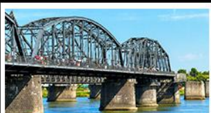
สะพานหวาดถานตง
